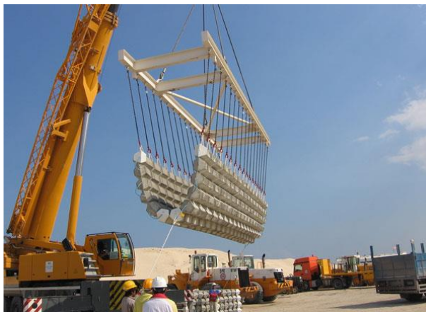
Fotografia 4. Elastyczne materace betonowe
