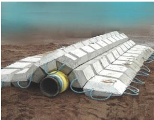
Rysunek 7. Elastyczny materac betonowy ułożony nad istniejącym rurociągiem
