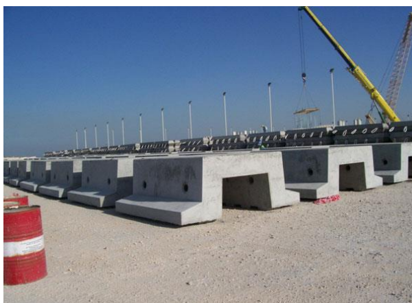
Fotografia 3. Prefabrykowane, betonowe obudowy do ochrony istniejących struktur liniowych
